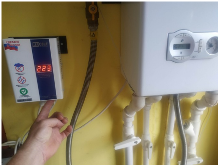
Рисунок 4: Перед подключением - обесточьте котел
